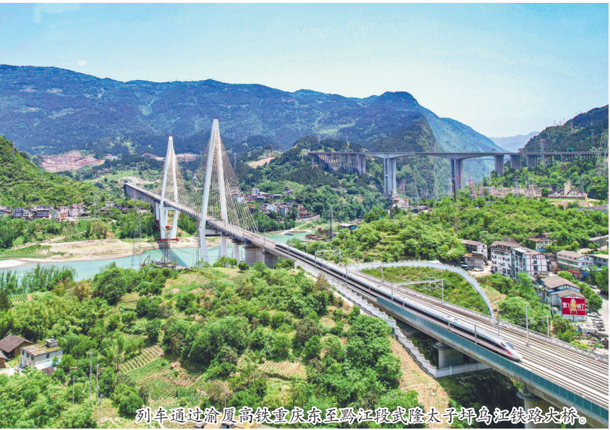
列车通过渝厦高铁重庆东至黔江段武隆太子坪乌江铁路大桥。
