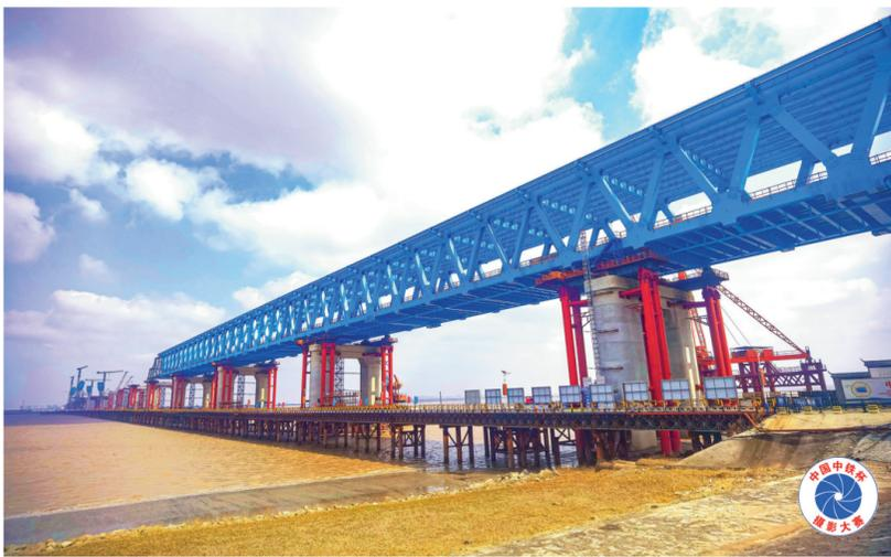
3月10日,在新建沪渝蓉高铁沪宁段崇启公铁长江大桥建设现场,随着E41-E42号钢梁节间顶推到位,非通航孔钢箱梁完成第7轮112米顶推作业,标志着钢箱梁顶推施工完成过半。
